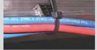
Horizontale Kabelführung
