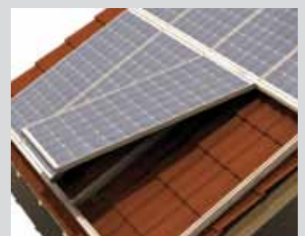
Module einlegen - fertig
