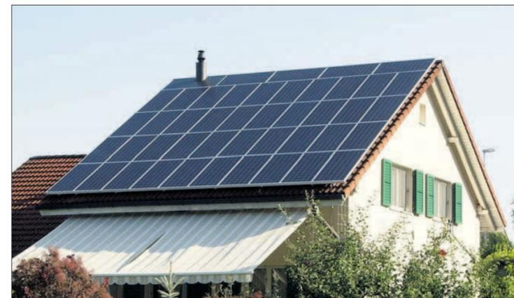
Photovoltaik Anlage mit einer Leistung von 8.8 kW.
